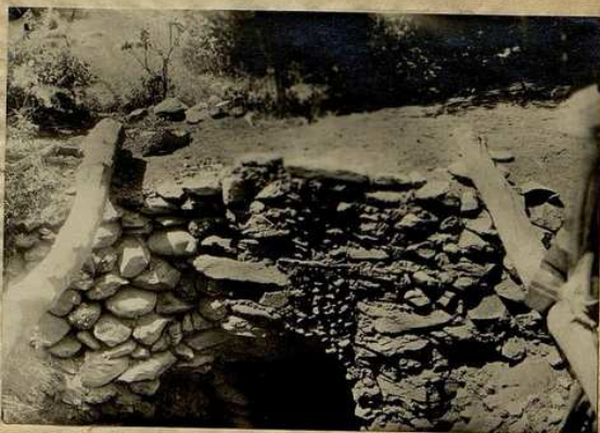
Вид опорожненной домны (с раскрытой крышей над помещением, пред домной) в сел. Ширговат, Ванч.
