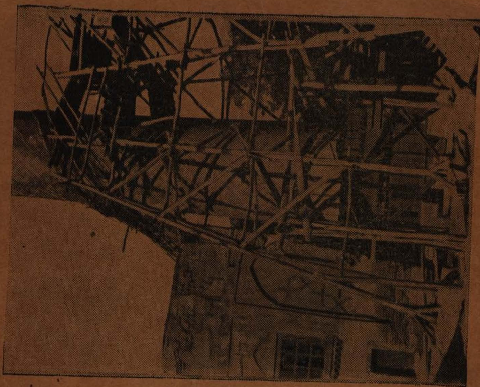
Металлическая конструкция в основании ного минарета медресе Улубека в Самарканде.
