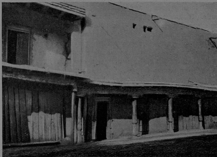
Жилой дом с торговыми помещениями в 1-м этаже
