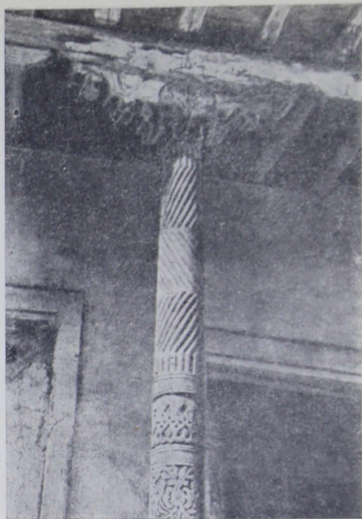
Рис. 12. Верхняя часть резной колонны в айване жилого дома
