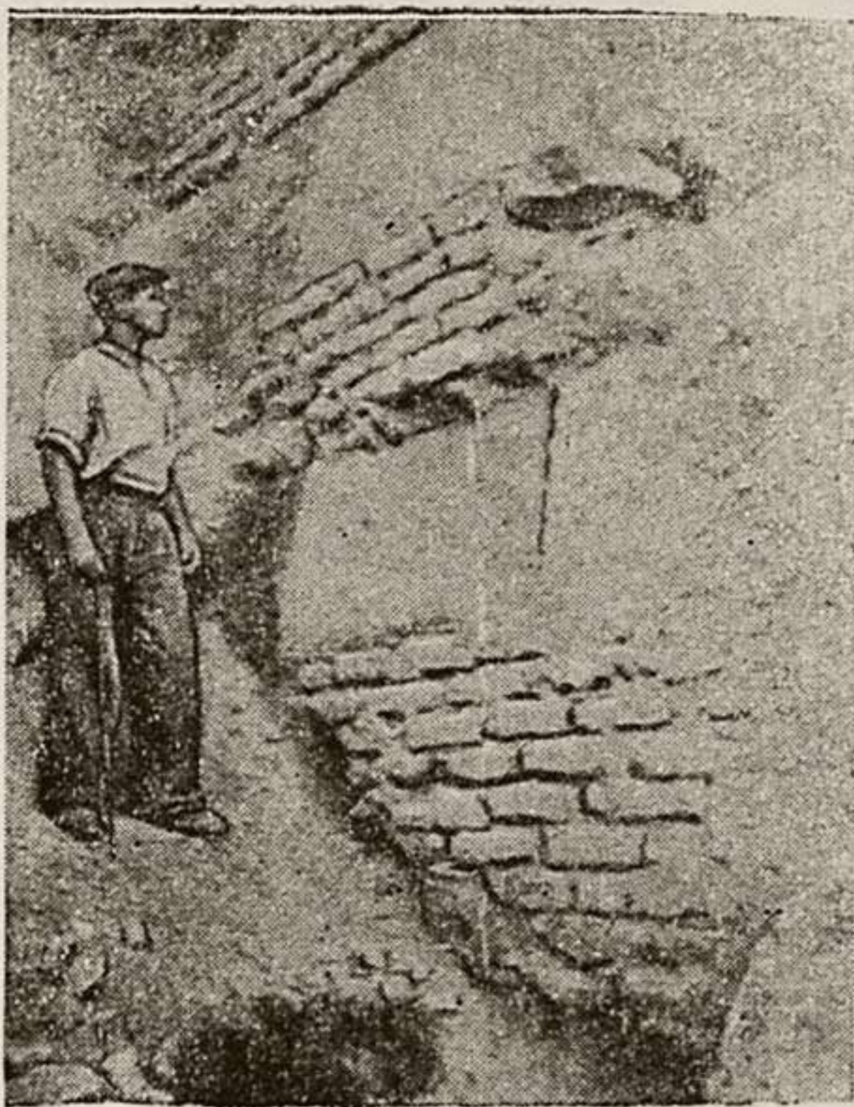
Рис. 1. Участок кладки крепостной стены.
