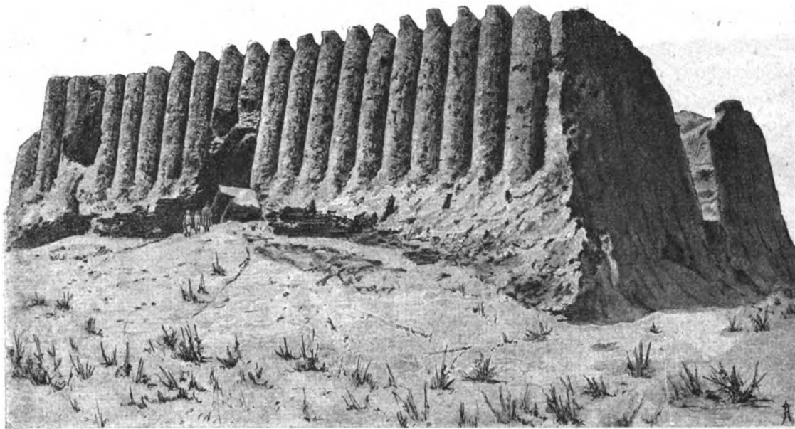
Рис. 25. Восточная сторона бѣльшаго изъ зданій «Кызъ-Кала».
