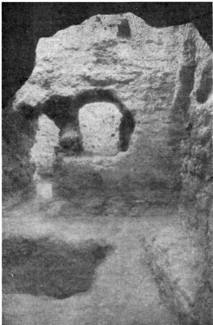
Рис. 13. Вид на окно между помещениями 6 и 5.
