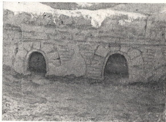
Рис. 7. Объект I. Помещение 5. Ниши в северной стене.
