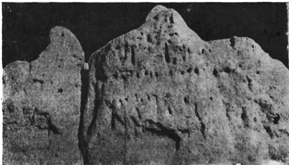
Рис. 44. Бойницы в северной стене помещения 2 (с наружной стороны)
