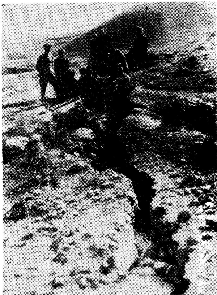
Рис 7. Трещины в слоях земли в эпицентре.
