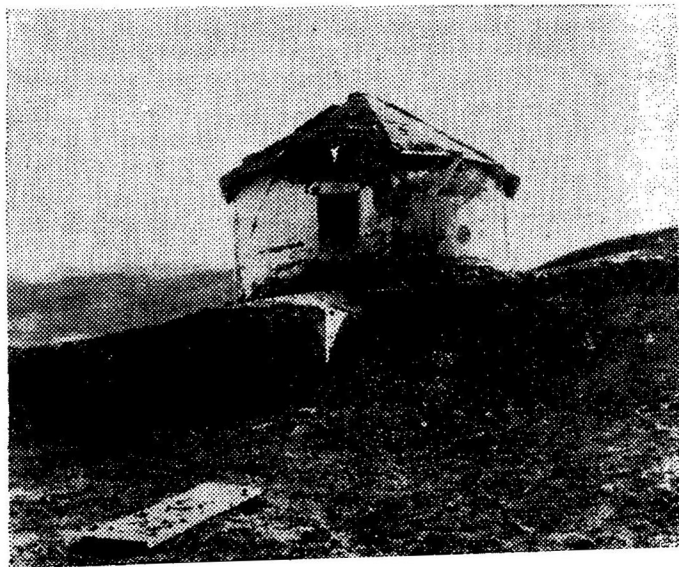
Рис 4. Сохранившееся округлое сооружение в районе эпицентра.
