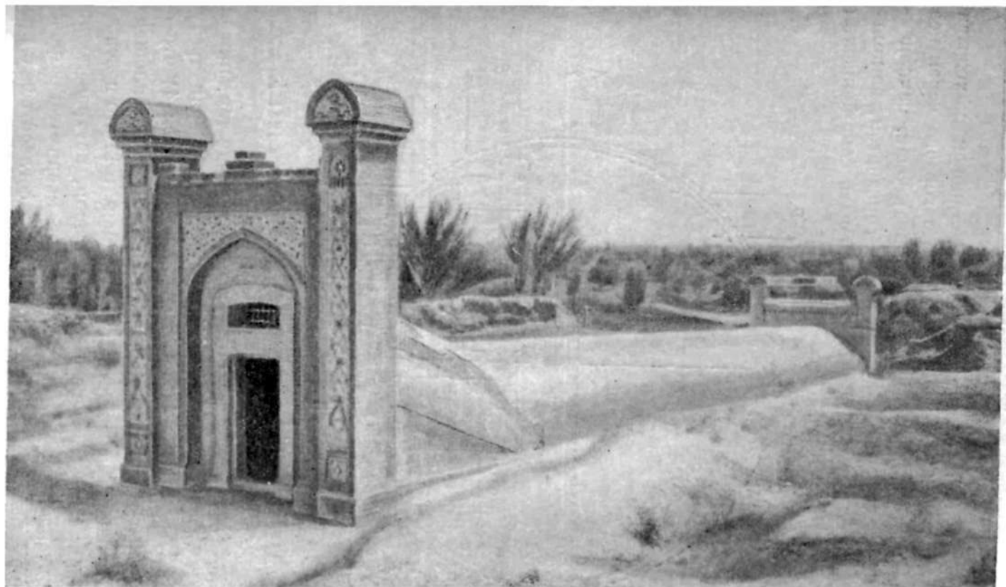
Рис. 32. Самарканд. Сводчатое перекрытие над главным инструментом обсерватории Улугбека, сооруженное в 1914 г.
